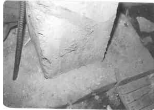
شكل 5: تشقق قاعدة العمود بعد ارتفاع مستوى المياه الجوفية [20].
